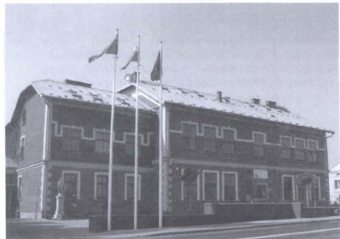
W budynku Urzędu Gminy wymieniono okna na drewniane
